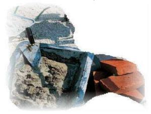
Ciment + sable + eau = mortier de ciment associé à une recherche de résistance, prise et durcissement rapide.
