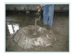
Les mortiers de chaux trouveront souvent leur place en habillage de façade, jointoiement de briques de parement, c'est à dire sur des matériaux plus tendres.
