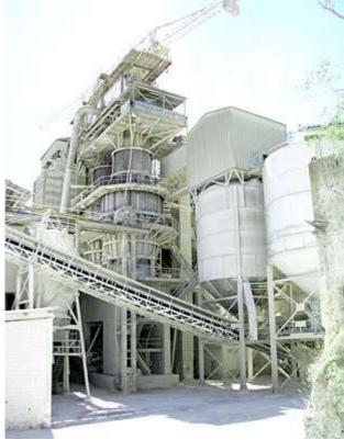
Les CHAUX sont des calcaires calcinés à 900°C dans des fours rotatifs auxquels on additionne des matériaux pour obtenir :
