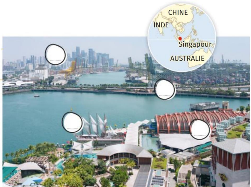
▲ Vue aérienne du port de Singapour, 2018.
